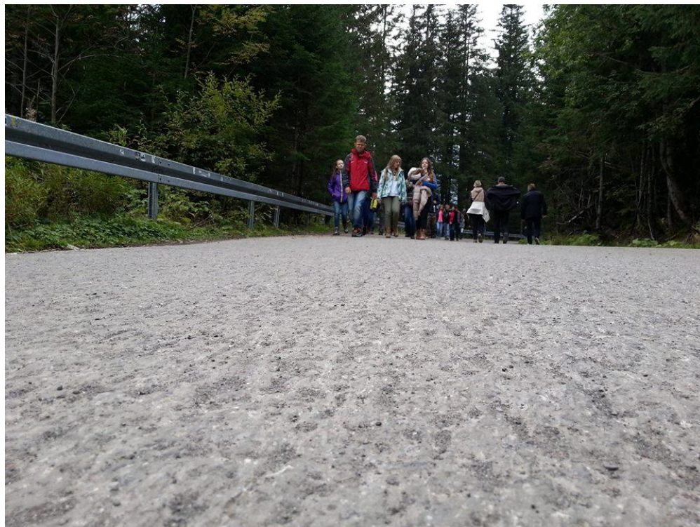
Rys1. Zniszczenie nawierzchni drogi do Morskiego Oka w 5. lat po remoncie ( archiwum TTONZ, 2014r)
